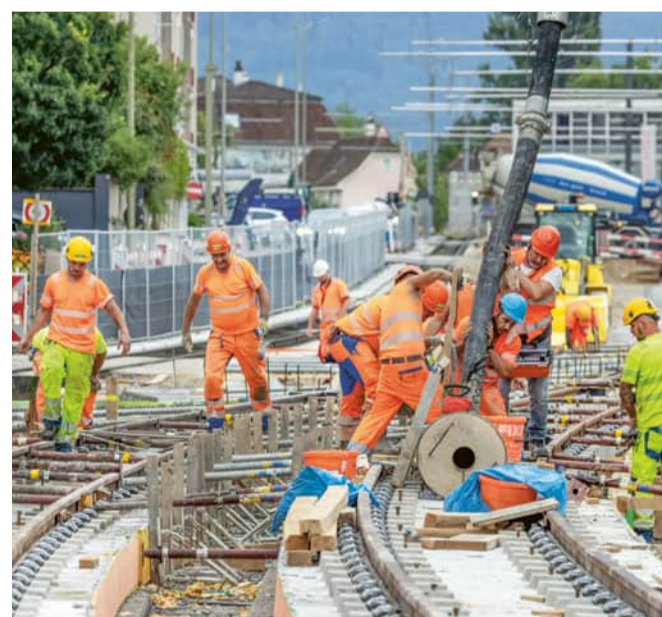
Trassearbeiten in vollem Gange
